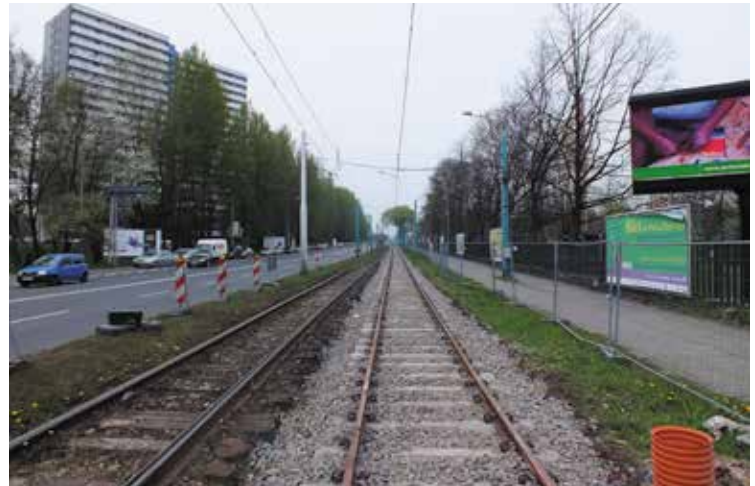
Torowisko wzdłuż ul. Chorzowskiej w Katowicach przy Wesolym Miasteczku.
