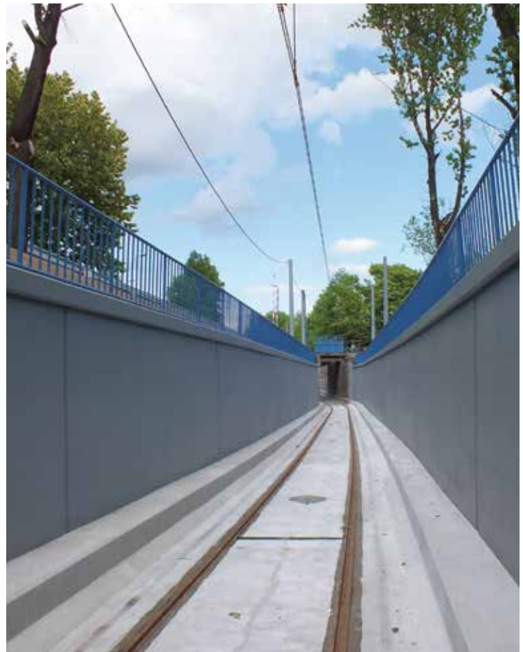
Tunel pod linią kolejową w Rudzie Śląskiej.
