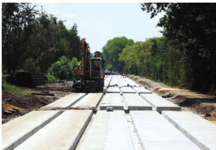
Katowice Szopienice, ul. Sosnowiecka.
