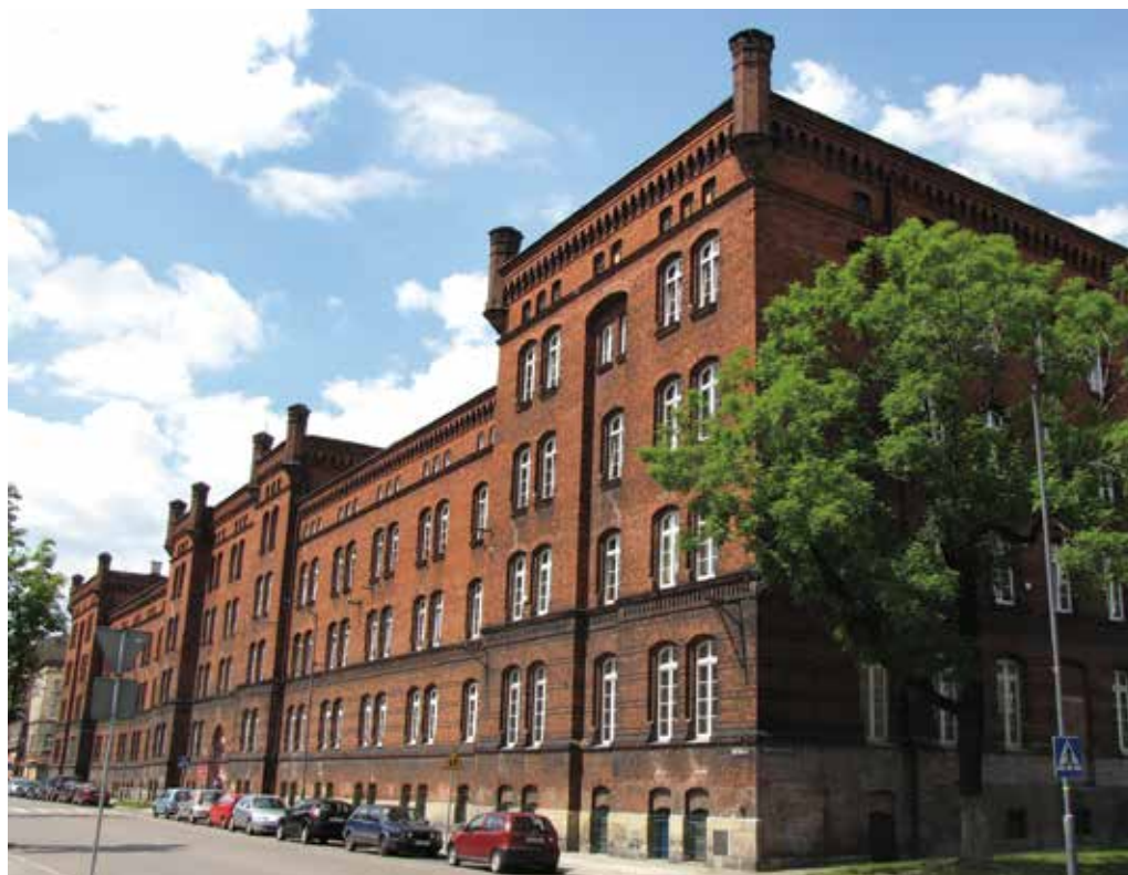
Budynek dawnych koszar.
