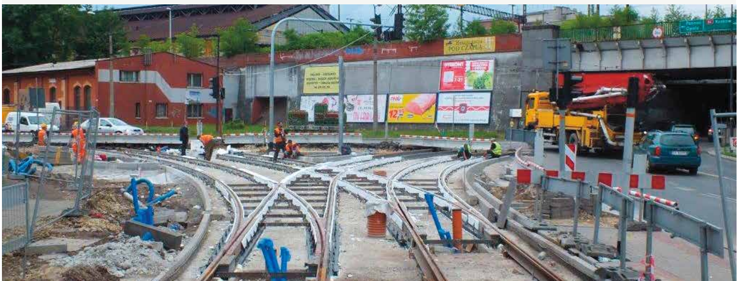
Bytom Zamłynie - rozjazd na skrzyżowaniu ul. Łagiewnickiej i Zabrzeńskiej.
