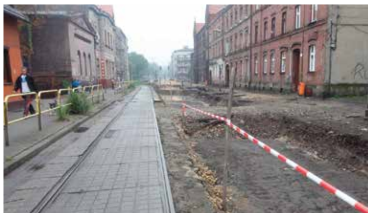
Rozpoczęte prace na ul. Obrońców Westerplatte w Katowicach.
