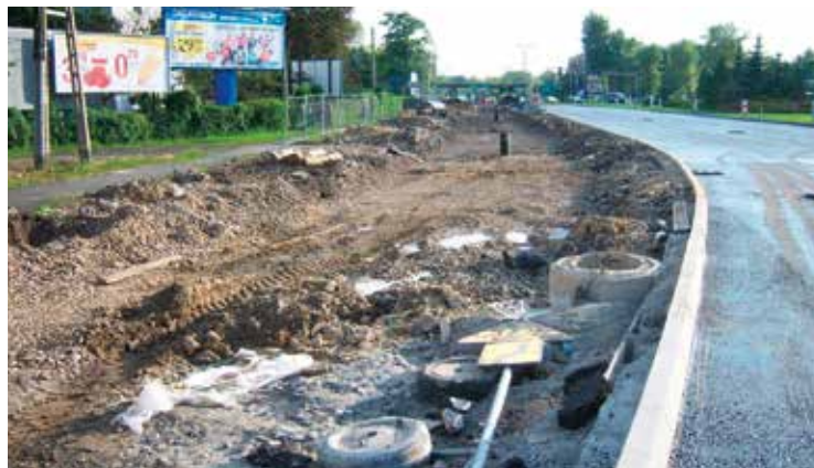
Dojazd do pętli w Katowicach Brynowie.
