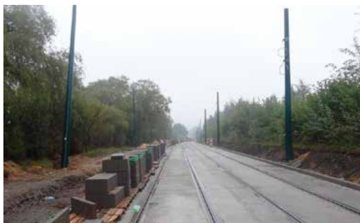
Przebudowywane połączenie torowe Katowic i Sosnowca.
