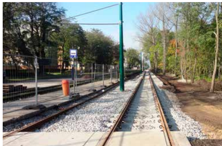
Katowice, ul. Gliwicka.
