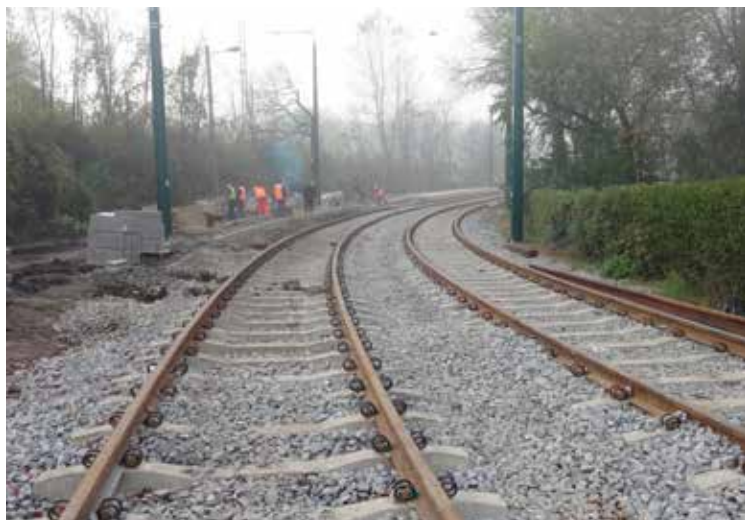
Katowice Szopienice, ul. Sosnowiecka.
