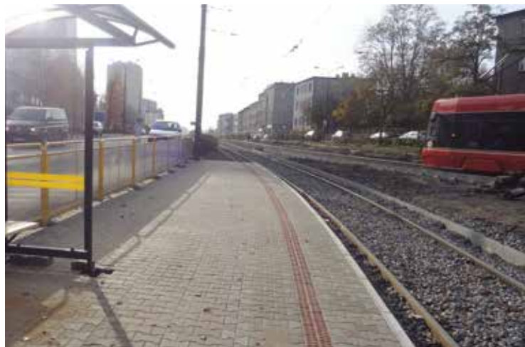
Katowice, Słoneczna pętla. Nowa platforma przystankowa.
