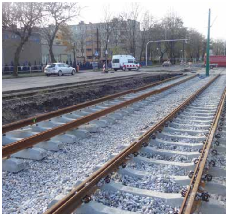
Katowice, ul. Gliwicka. Torowisko w nowym śladzie.
