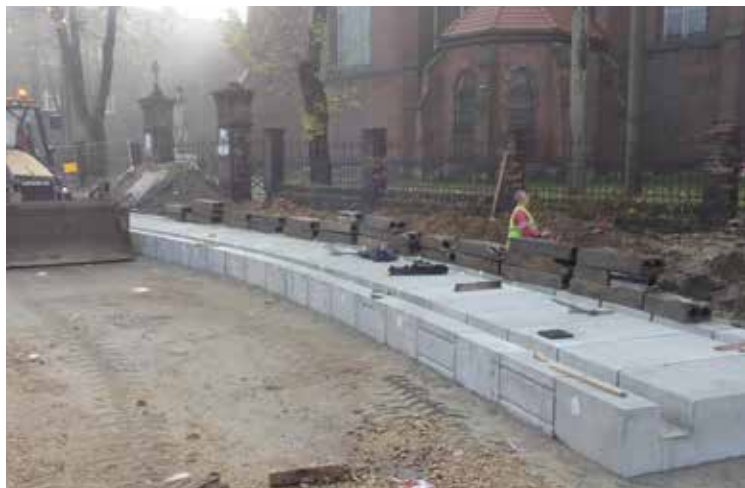
Katowice Szopienice, ul. Wiosny Ludów. Trwa układanie płyt torowych.
