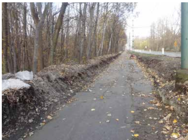
Świętochłowice, ul. Bytomska. Gotowa podbudowa pod pierwszy nowy tor.
