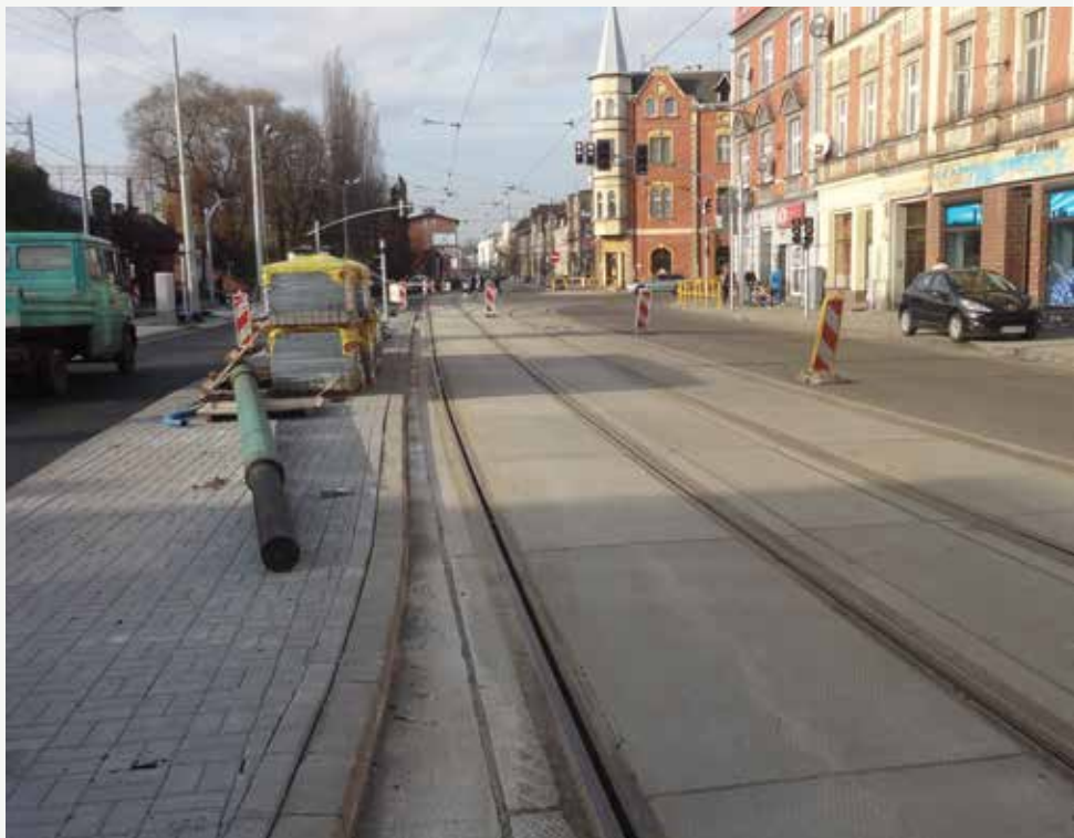
Chorzów, ul. Armii Krajowej. Nowa platforma przystankowa przy Dworcu PKP.
