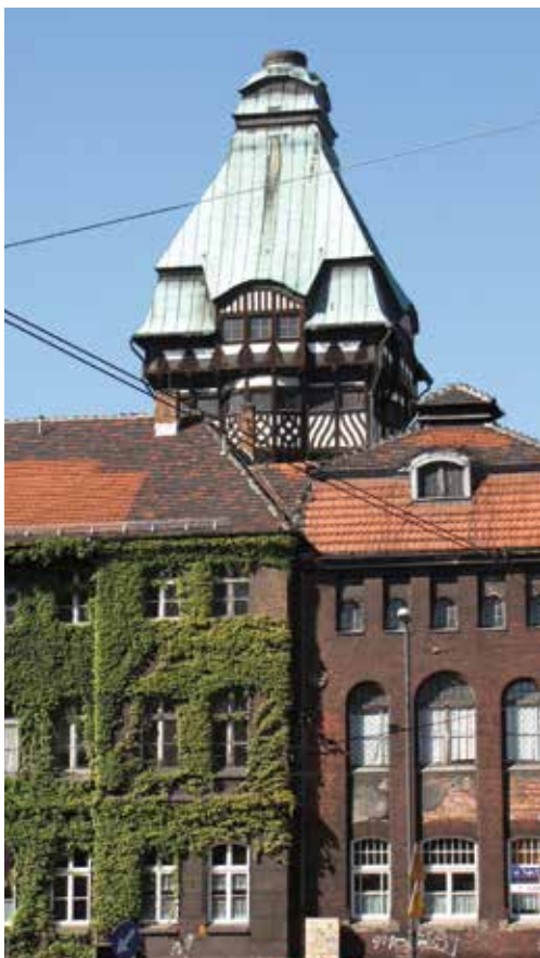
Wieża kominowo-ciśnieniowa szpitala klinicznego.
