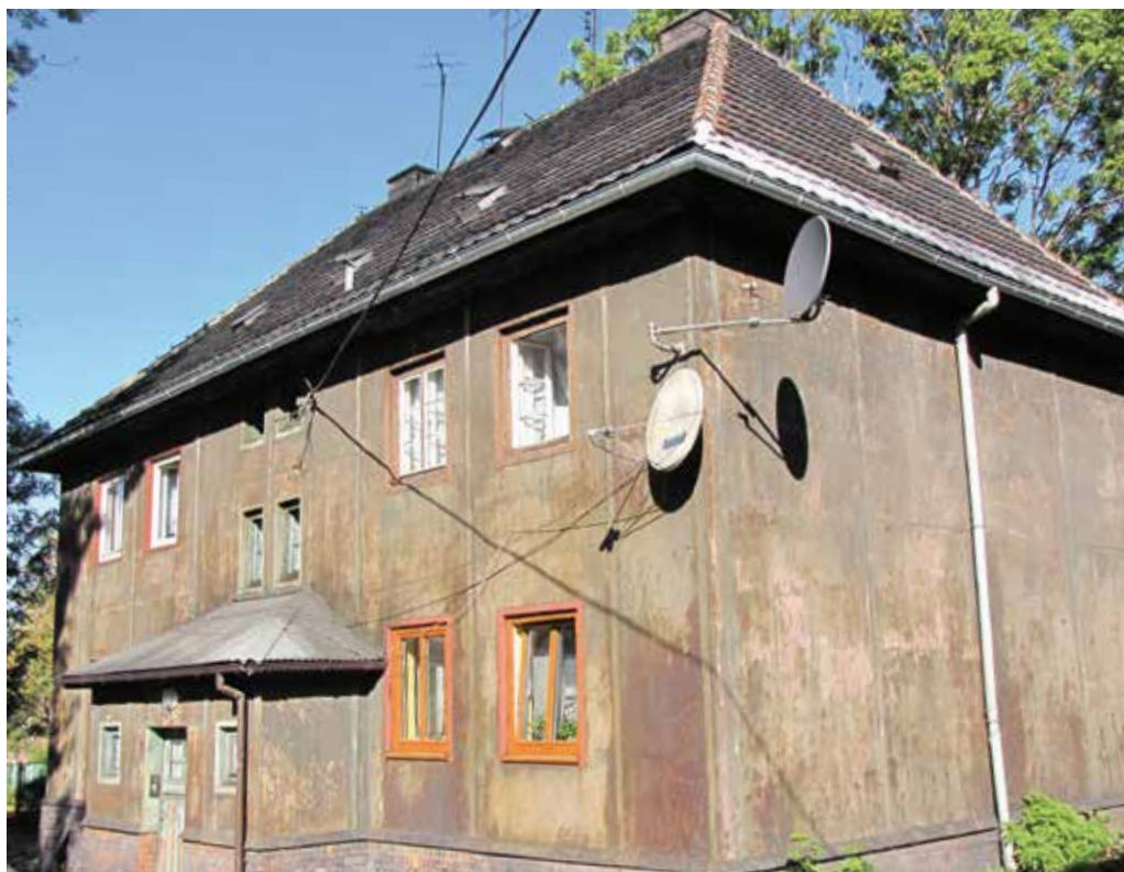
Stalowy dom przy ul. Cmentarnej.
