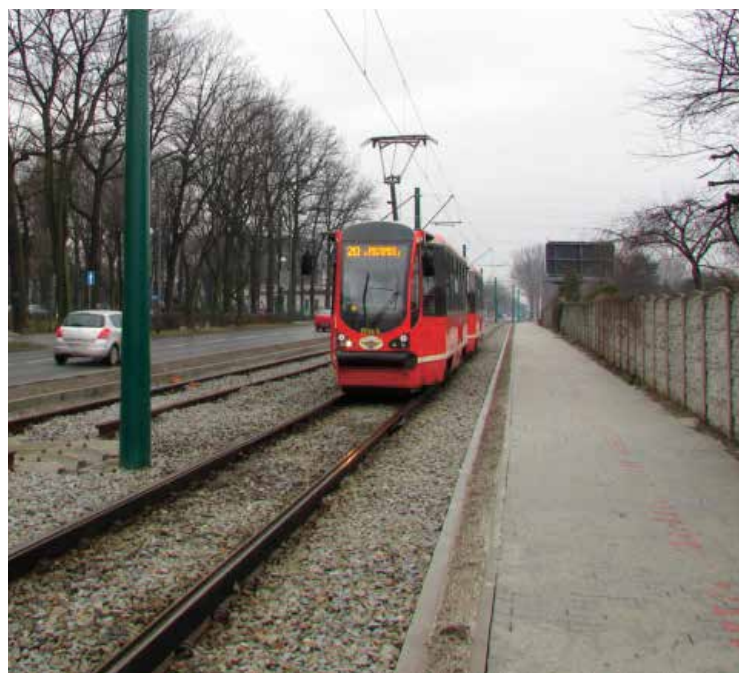
Katowice, ul. Gliwicka.
