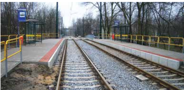
Katowice Szopienice, przystanek przy ul. Morawa.
