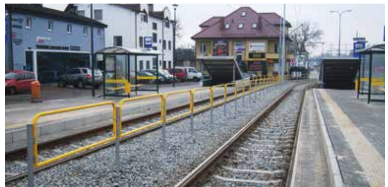
Katowice Brynów, przystanek przy ul. Słowików.
