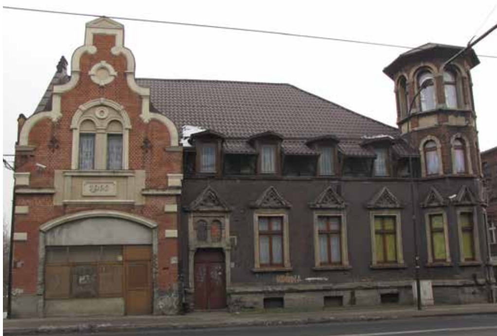
Budynek z 1900 r. przy ul. Świętochłowickiej.
