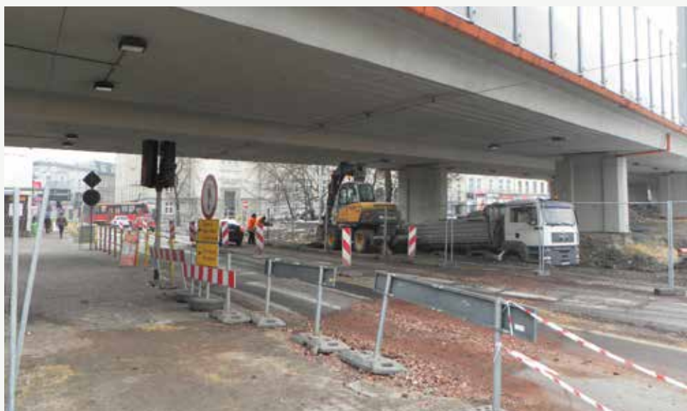
Chorzów – Rynek, budowa centrum przesiadkowego.
