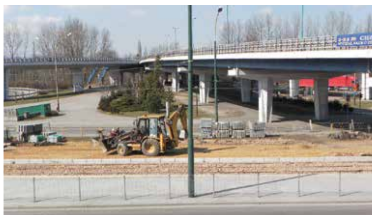
Sosnowiec, kończą się prace przy CWK.
