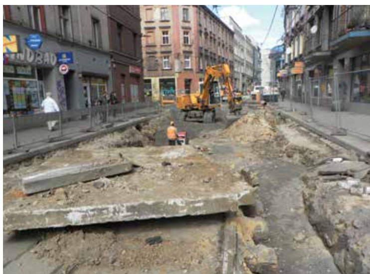
Bytom, ul. Katowicka.
