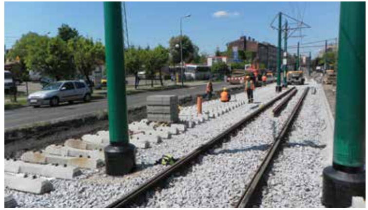
Katowice, ul. Gliwicka.
