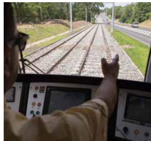
Odbudowana linia tramwajowa wzdłuż ul. Łagiewnickiej w Bytomiu.
