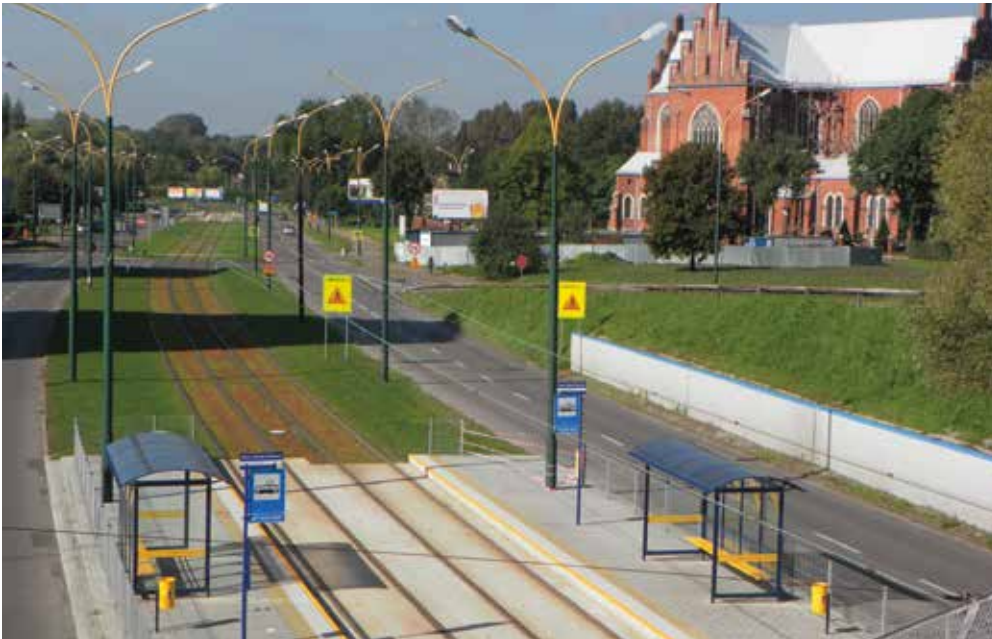
Przebudowane torowisko na ul. 3 Maja w Sosnowcu.
