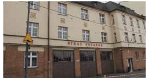
Budynek Straży Pożarnej przy ul. Wojewódzkiej.
