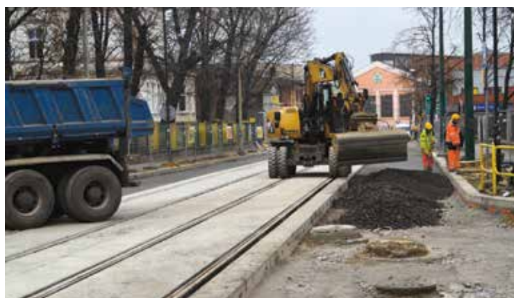
Trwające prace w zakresie drogowym na ul. Brysza w Zabrzu.
