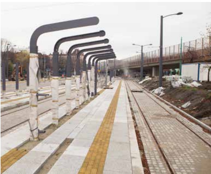
Na peronach centrum przesiadkowego na chorzowskim Rynku stoją już konstrukcje wiat.
