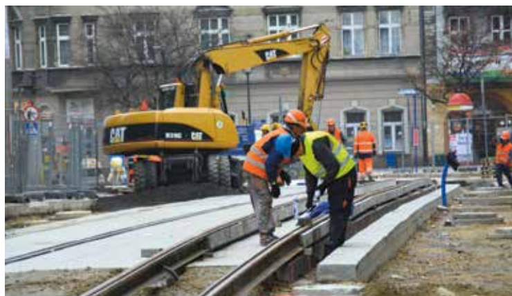
Montaż szyn na ciągu ulic: Brysza, pl. Krakowski, Lutra w Zabrzu.
