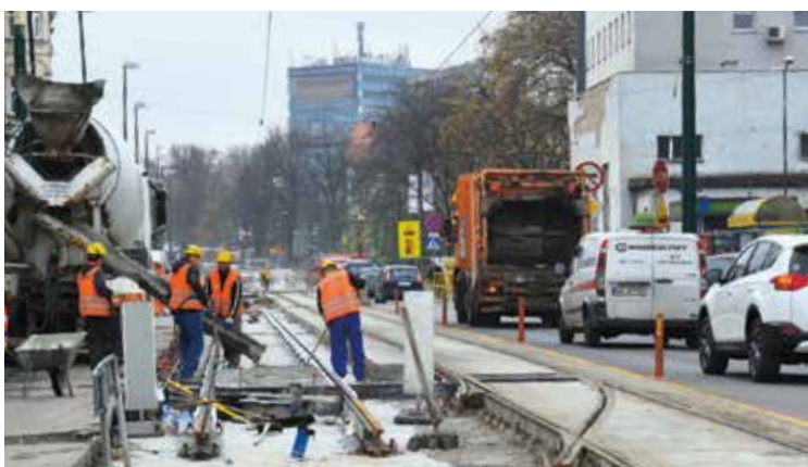
Prace przy drugim torze na ul. Wolności w Zabrzu.
