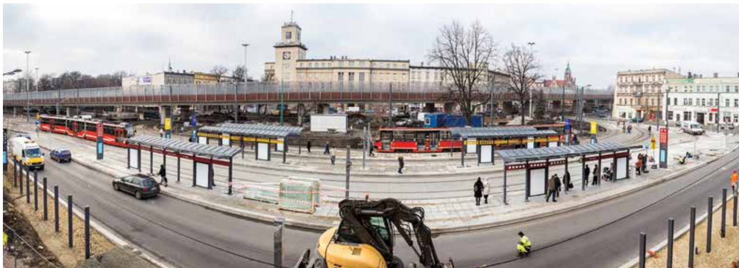
Chorzów, centrum przesiadkowe.
