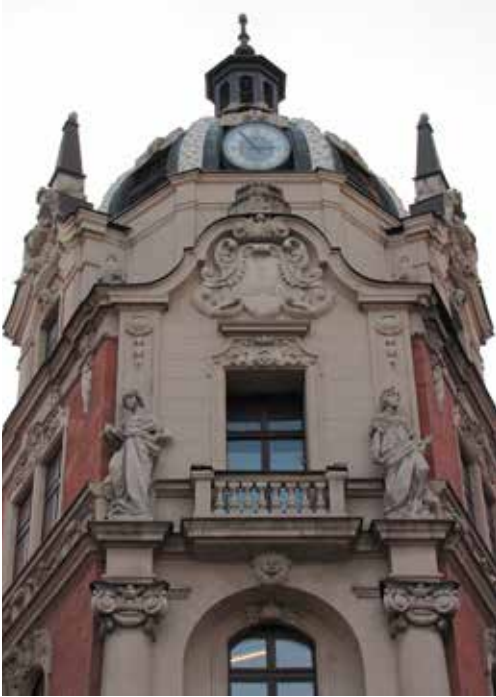
Naroże budynku przy ul. Pocztovej i Młyńskiej.
