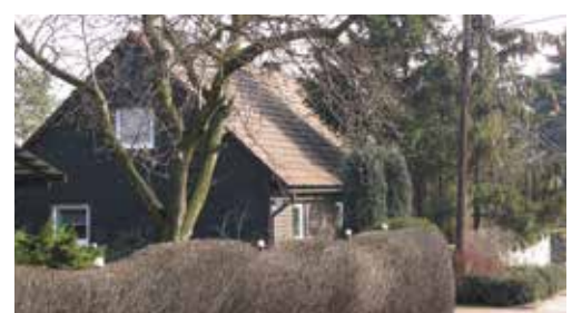
Zabudowa tzw. fińskich domów przy ul. Witczaka.
