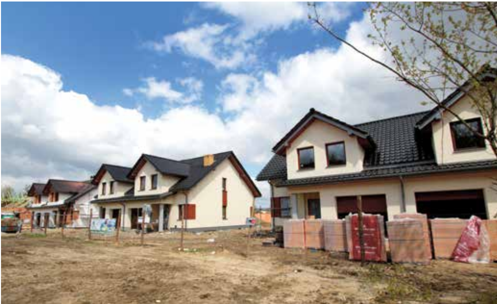
W Czeladzi powstaje kilka nowych osiedli. Jedno z nich budowane jest przy ul. Wiosennej.
