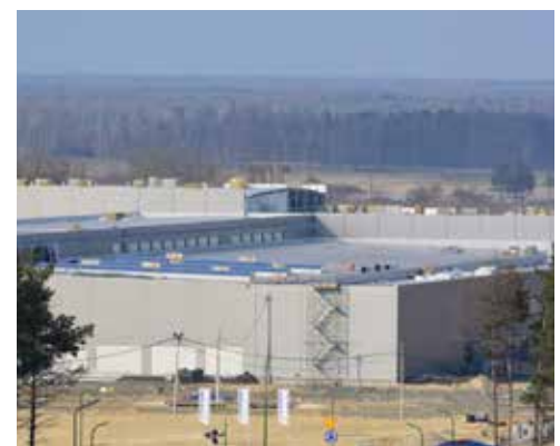
Budowa fabryki NGK.
