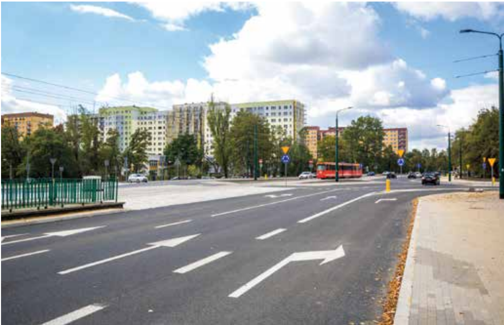
Wybudowane w 2015 roku rondo u zbiegu ulic Piłsudskiego, Grabowej i Kierocińskiej
