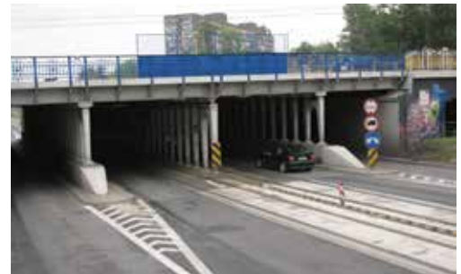
Wiadukt przy ul. Józefa Piłsudskiego
