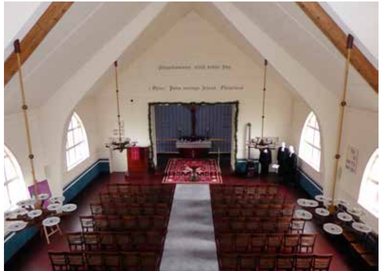
Kościół ma drewniany szkielet, a całą konstrukcję spajają dwie pary dźwigarów z klejonego drewna. Trzecią parę celowo pozostawiono odsłoniętą
