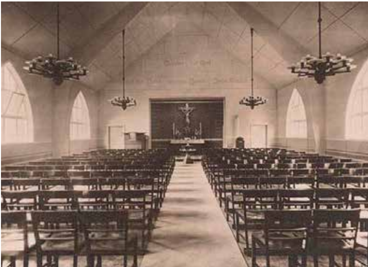
Kościół ma drewniany szkielet, a całą konstrukcję spajają dwie pary dźwigarów z klejonego drewna. Trzecią parę celowo pozostawiono odsłoniętą
