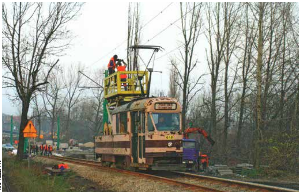
Wagon wieżowy utrzymania sieci trakcyjnej nr 61R, Ruda Śląska Chebzie, 2006 rok
