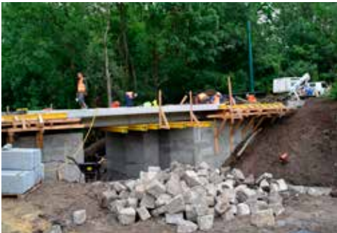
Zabrze, most nad potokiem Julka
