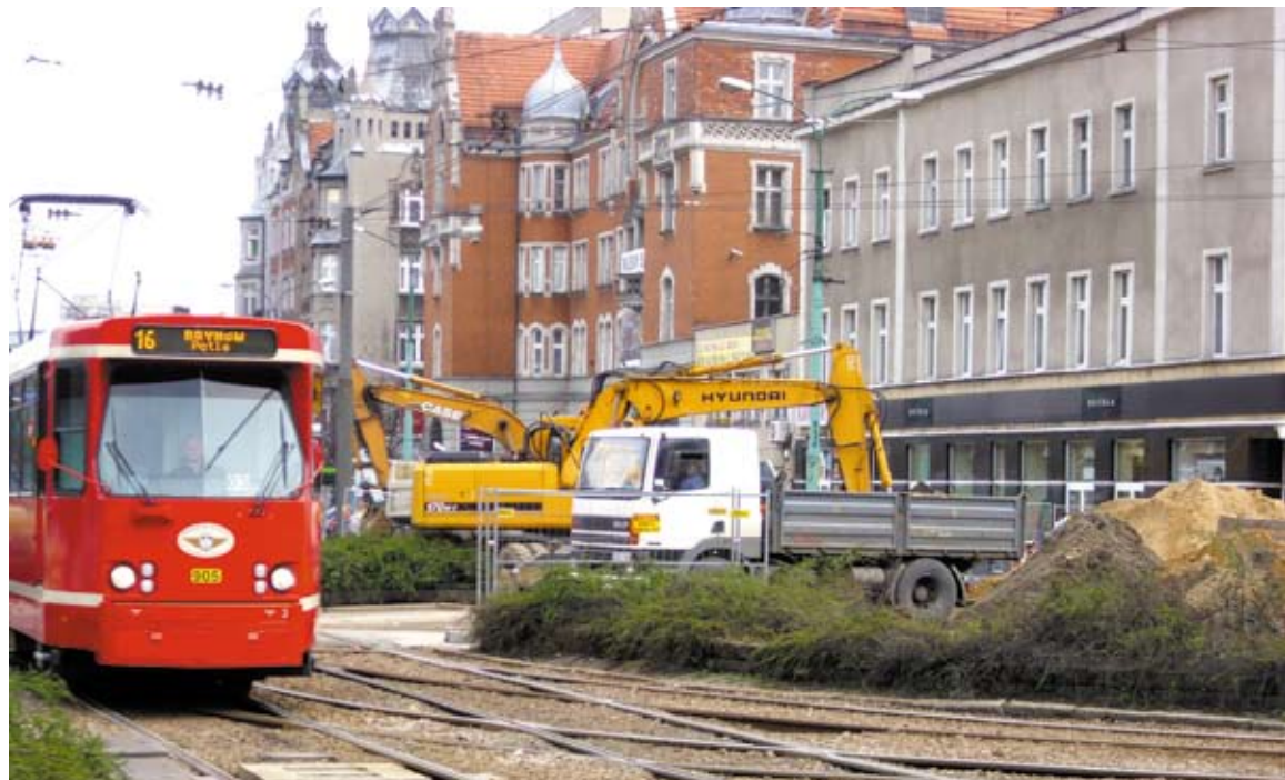
W czasie przebudowy Rynku potwierdziła się przydatność wagonów dwukierunkowych Pt 8.
