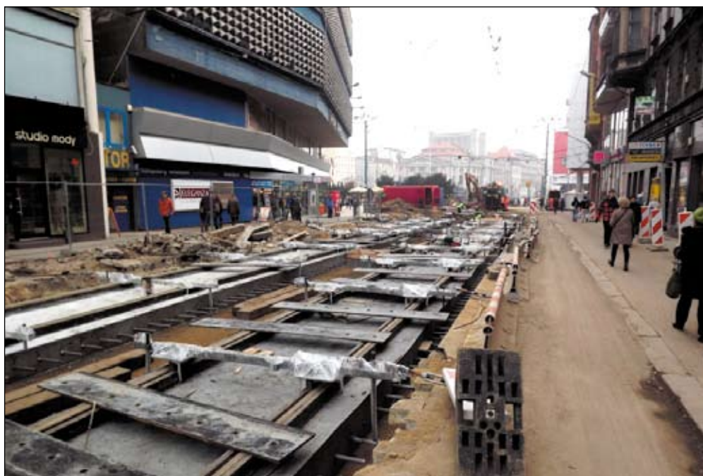
Przebudowa torowiska w ul. 3-go Maja w Katowicach.
