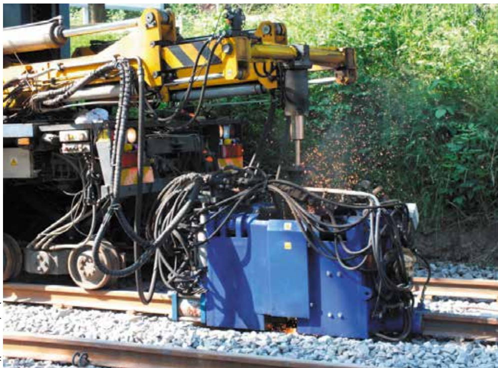
Zgrzewanie szyn przy montażu torowiska wzdłuż Parku Śląskiego.
