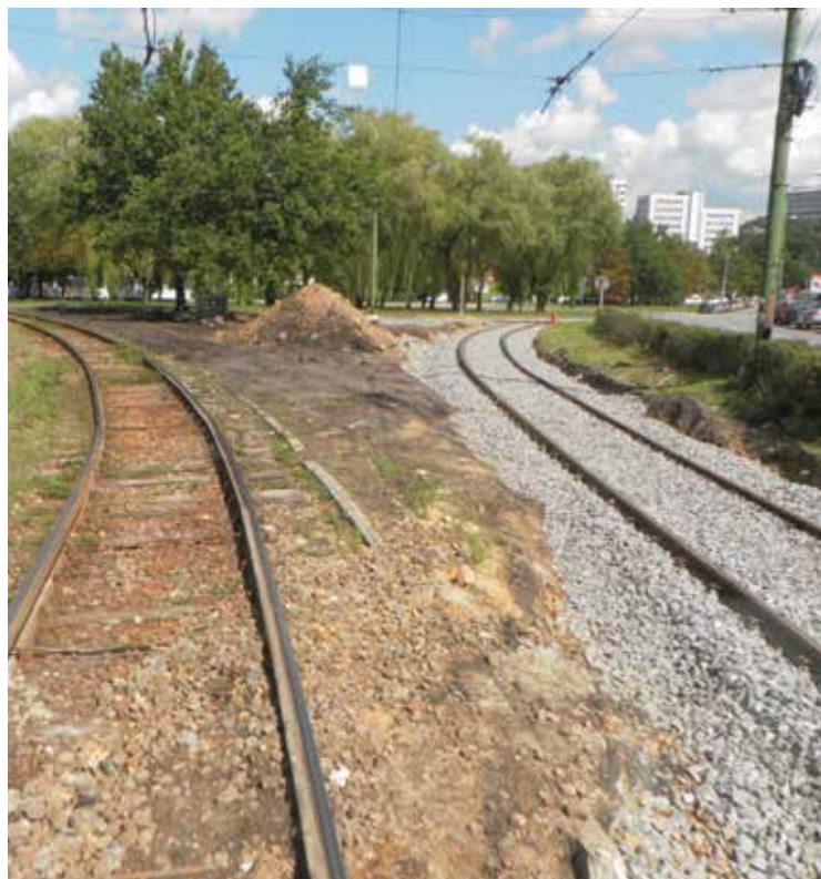
Trwają prace przy pętli Słonecznej w Katowicach.
