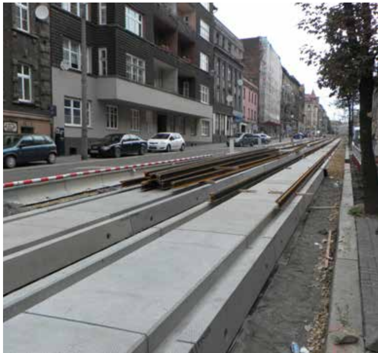
Bytom, ul. Jagiellońska - trwa układanie szyn.
