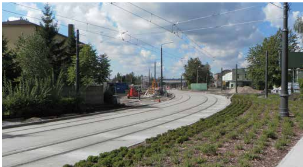
Katowice Burowiec – nowe torowisko.
