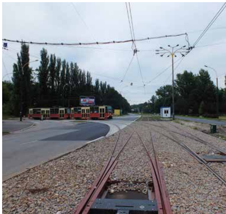
Zakończone prace torowe na skrzyżowaniu ulic 3 Maja i Żeromskiego w Sosnowcu
