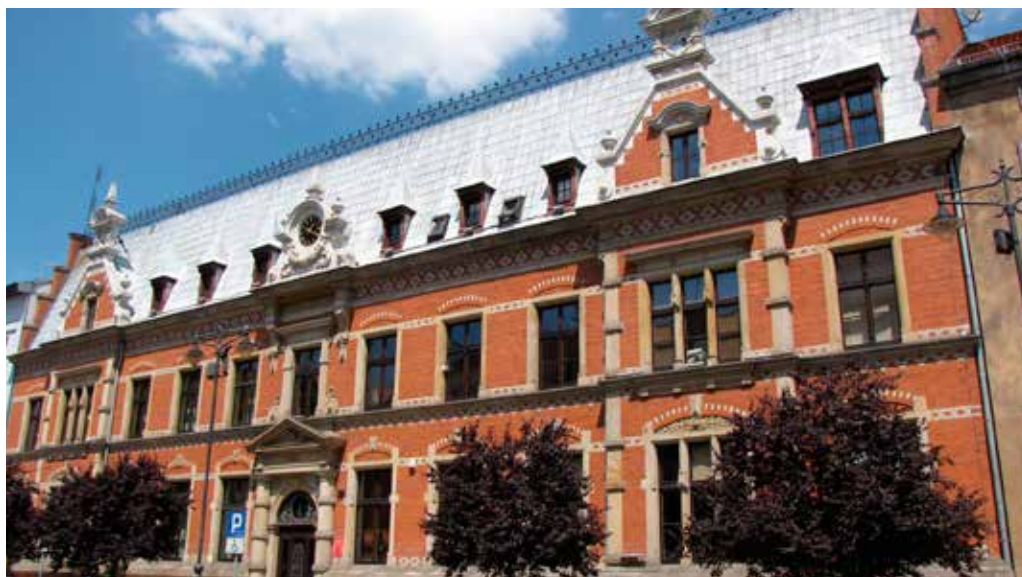
Budynek przy pl. Inwalidów Wojennych – siedziba Urzędu Pracy.
