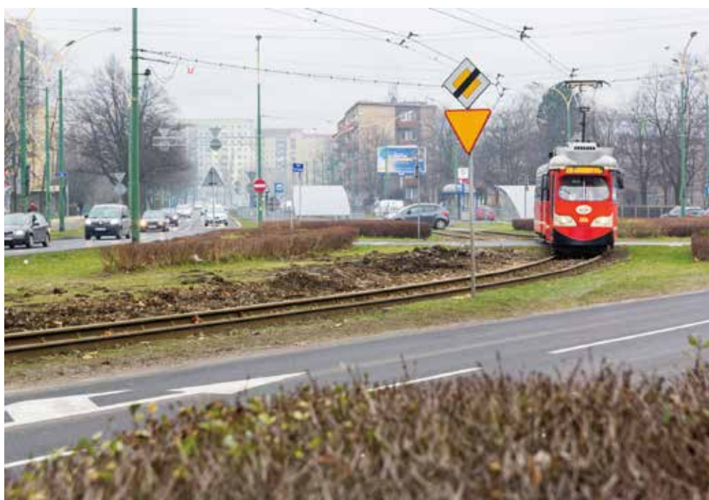
W listopadzie br. rozpoczęły się prace w Sosnowcu, w ramach zadania pod nazwą: „Budowa i modernizacja infrastruktury torowo-sięciowej w ciągu ul. Piłsudskiego w Sosnowcu od ul. Sołbieńskiego do drogi ekspresowej S86”
