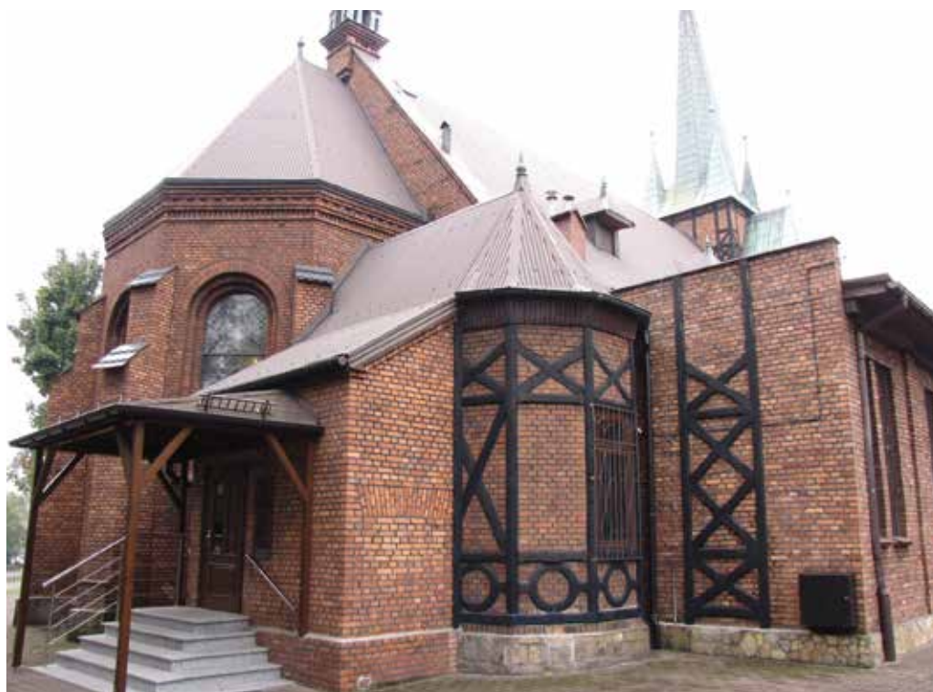
Kościół pw. Matki Bożej Różańcowej wykonany został z czerwonej cegły, z charakterystycznymi elementami tzw. muru pruskiego
