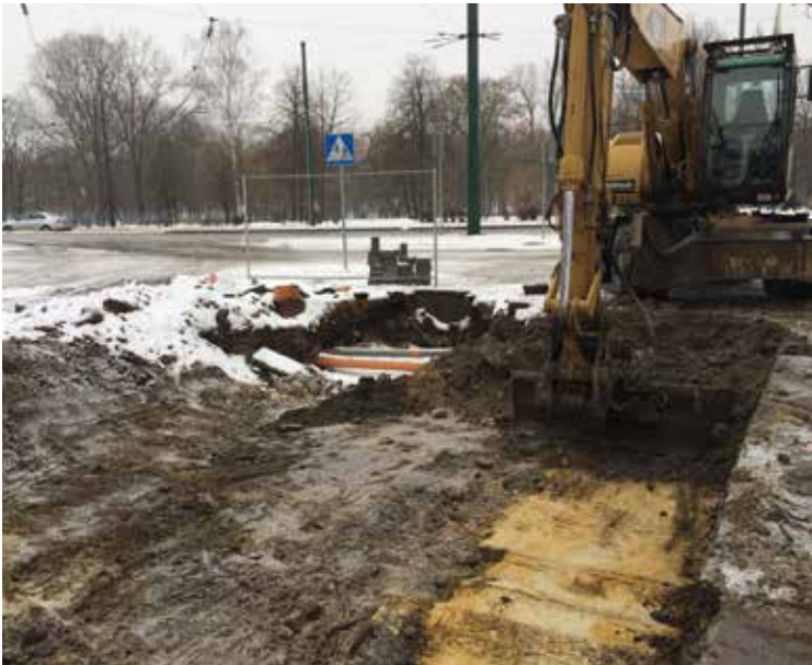
Sosnowiec, prace w rejonie wiaduktu kolejowego
