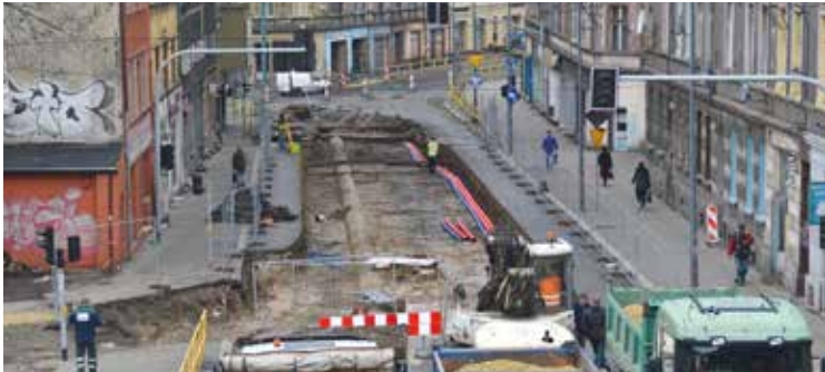
Bytom, ul. Siemianowicka
