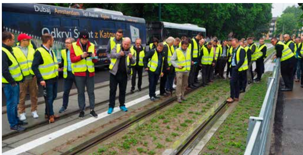
Zmodernizowane torowisko w Sosnowcu
