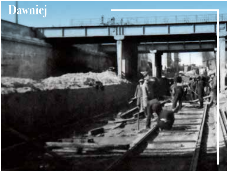
Sosnowiec, październik 1930 r. Układanie toru pod wiaduktem kolejowym w Sosnowcu
