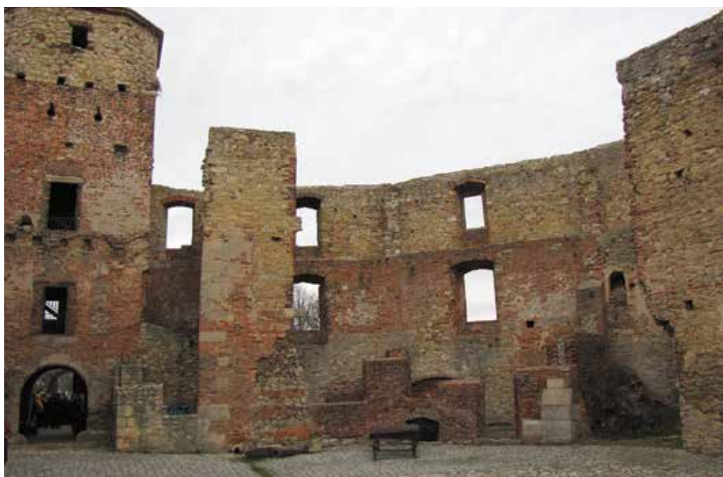
Pozostałości zamkowego dziedzińca
