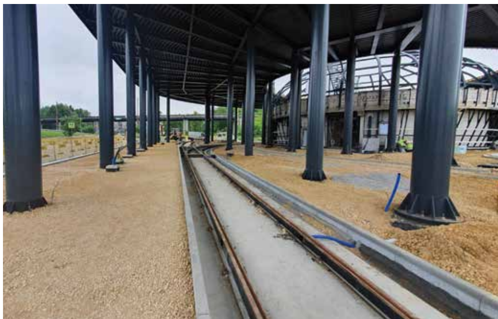
Budowa centrum przesiadkowego w Katowicach Brynowie
