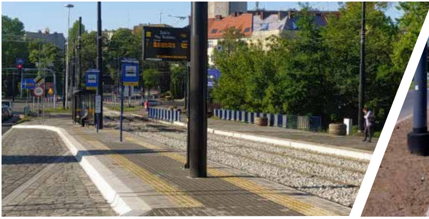
Zakończone prace na ul. Wolności, Powstańców i Religi w Zabrzu.
