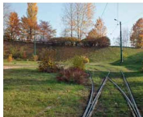
Od dotychczasowej pętli poprowadzona zostanie nowa linia tramwajowa
