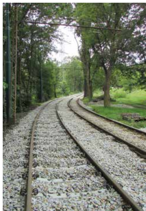
Zabrze, modernizowany odcinek wzdłuż ulicy Bytomskiej
