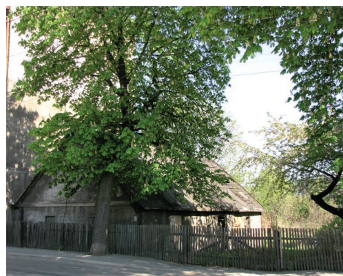
Jeden z najstarszych budynków Załęża przy ul. Gliwickiej
