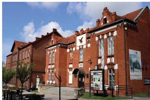
Budynek Miejskiego Centrum Kultury i Sportu, w którym kiedyś mieściło się Towarzystwo Gimnastyczne „Sokół”
