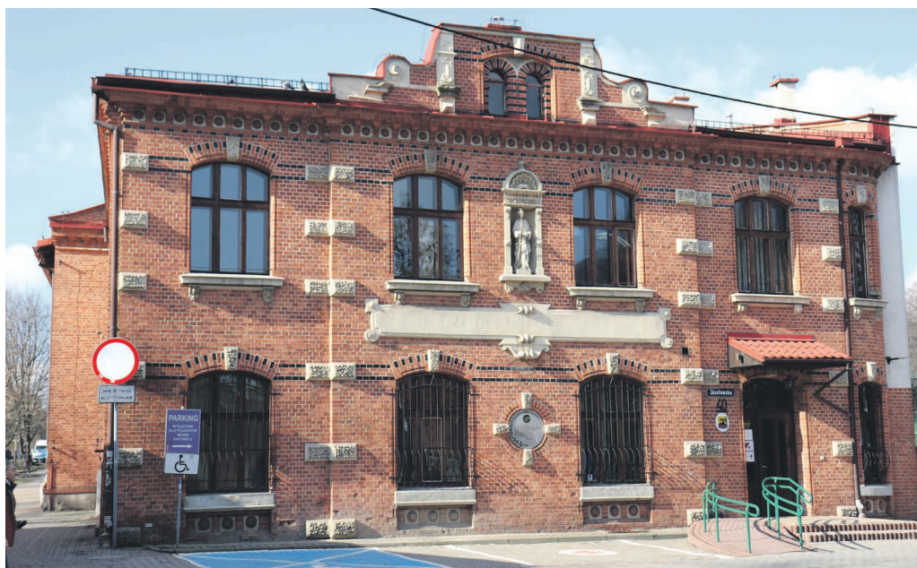
Budynek historycznej sali sportowej przy ul. Józefowskiej 40
