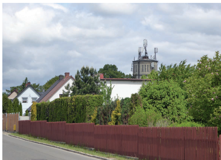
Wśród zabudowań na ulicy Gombrowicza wyrasta wieża wodna z 1938 roku
