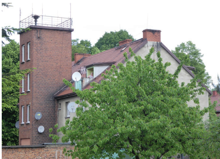
Budynek remizy strażackiej w Stolarzowicach
