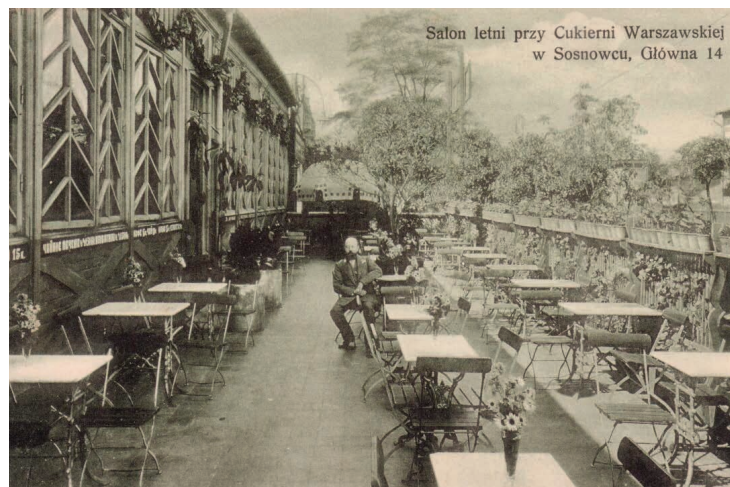
Cukiernia Warszawska, założona w 1880 roku, jeszcze we wsi Sosnowiec. Znajdowała się w miejscu, gdzie obecnie stoi budynek pod adresem 3 Maja 15
