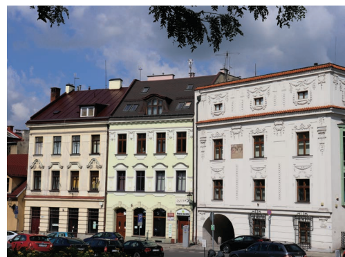
Zabudowa ul. Menniczej
