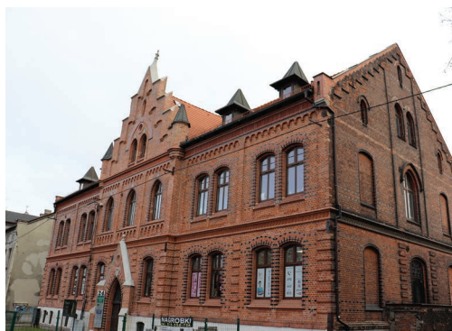
Budynek dawnego szpitala św. Joanny
