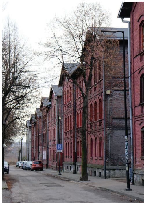
Widok na robotniczą zabudowę przy ul. E. Imieli
