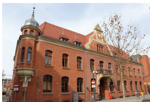
Budynek zabytkowej Poczty
