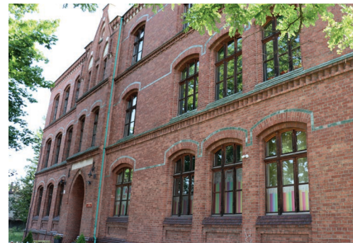
Zabytkowy budynek Przedszkola przy ul. Grzegorzka
