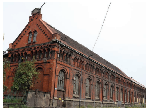
Budynek starej siłowni hutniczej przy ul. Konstytucji w Bobrku
