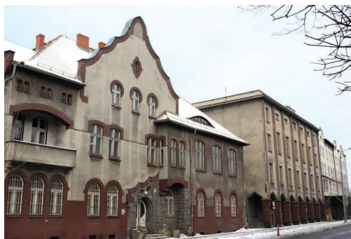
Budynek dawnego Urzędu Gminnego
