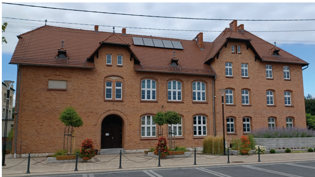
Budynek szkolny z 1904 roku przy ul. 1 Maja
