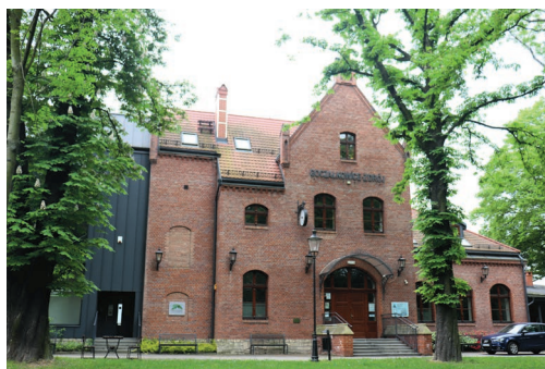
Budynek dworca kolejowego
