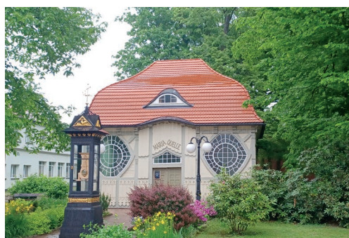
Pijalnia wód w budynku z 1862 roku
